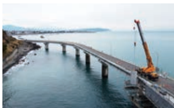
石部海上橋 耐震・補強工事
