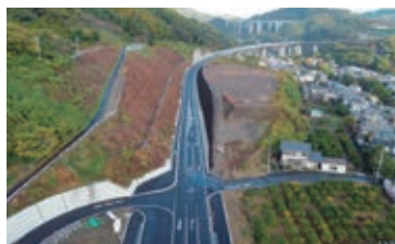
清水富士宮線(高架部)
